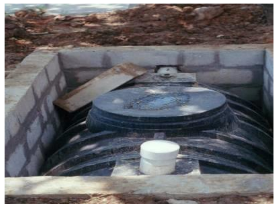
Gambar 4. Contoh Pemasangan Septik tank
