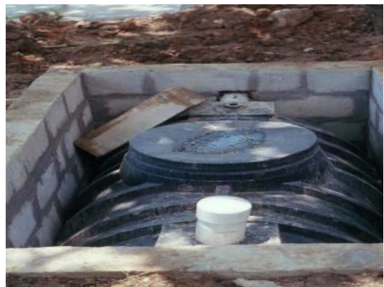
Gambar 4. Contoh Pemasangan Septik tank
